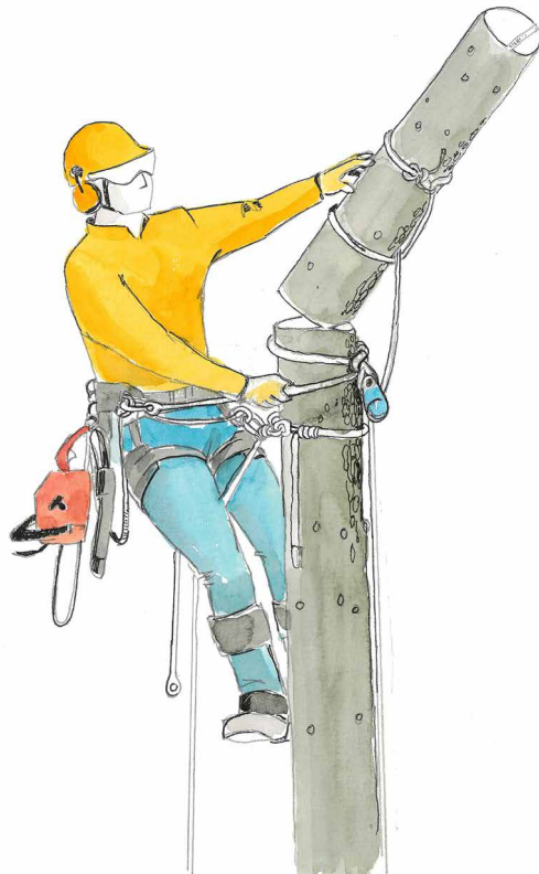
Kuva 12. Alas laskettavan rungon osan pudottaminen.
